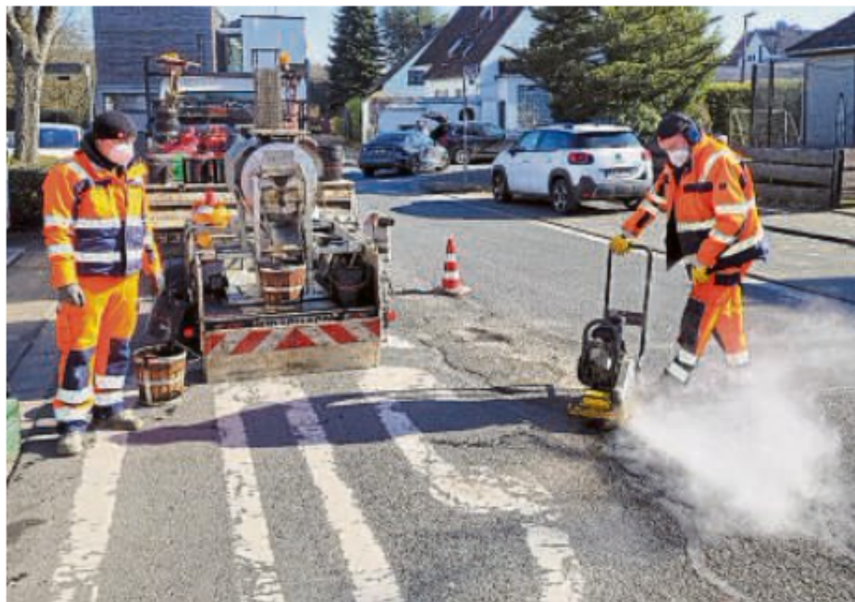
Bei der „MPRS“-Methode wird Heißasphalt in das Schlagloch gefüllt und mit der Maurerkelle verteilt. FOTO: SCHNEIDER
