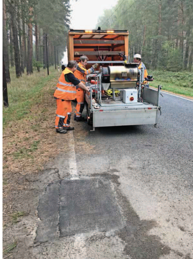
Schadstelle durch einen Wurzelschaden beseitigt – in hoher Qualität
