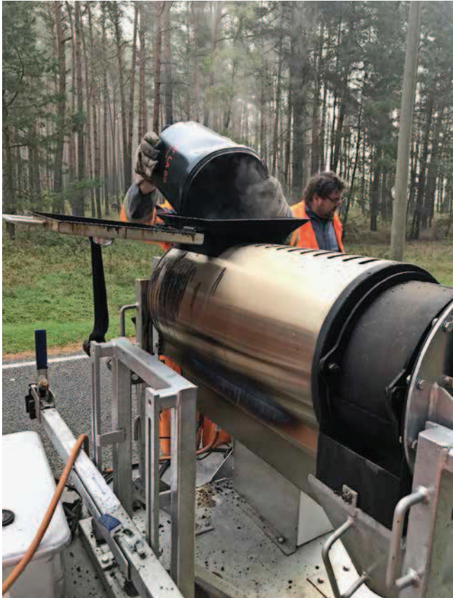
Die Aufgabe des Mischgutes in die Anlage
