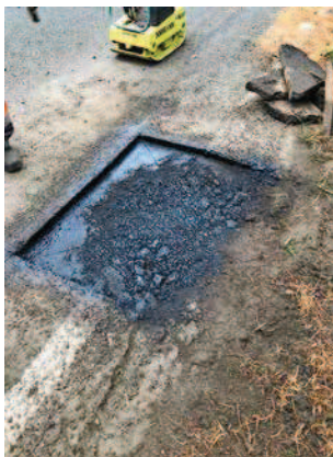
Die Aufgabe des Mischgutes in die Anlage
