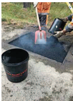
Der Einbau des heißen Materials
